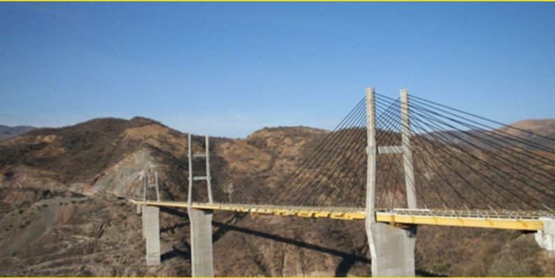
CONSTRUCCIÓN DE PUENTES
